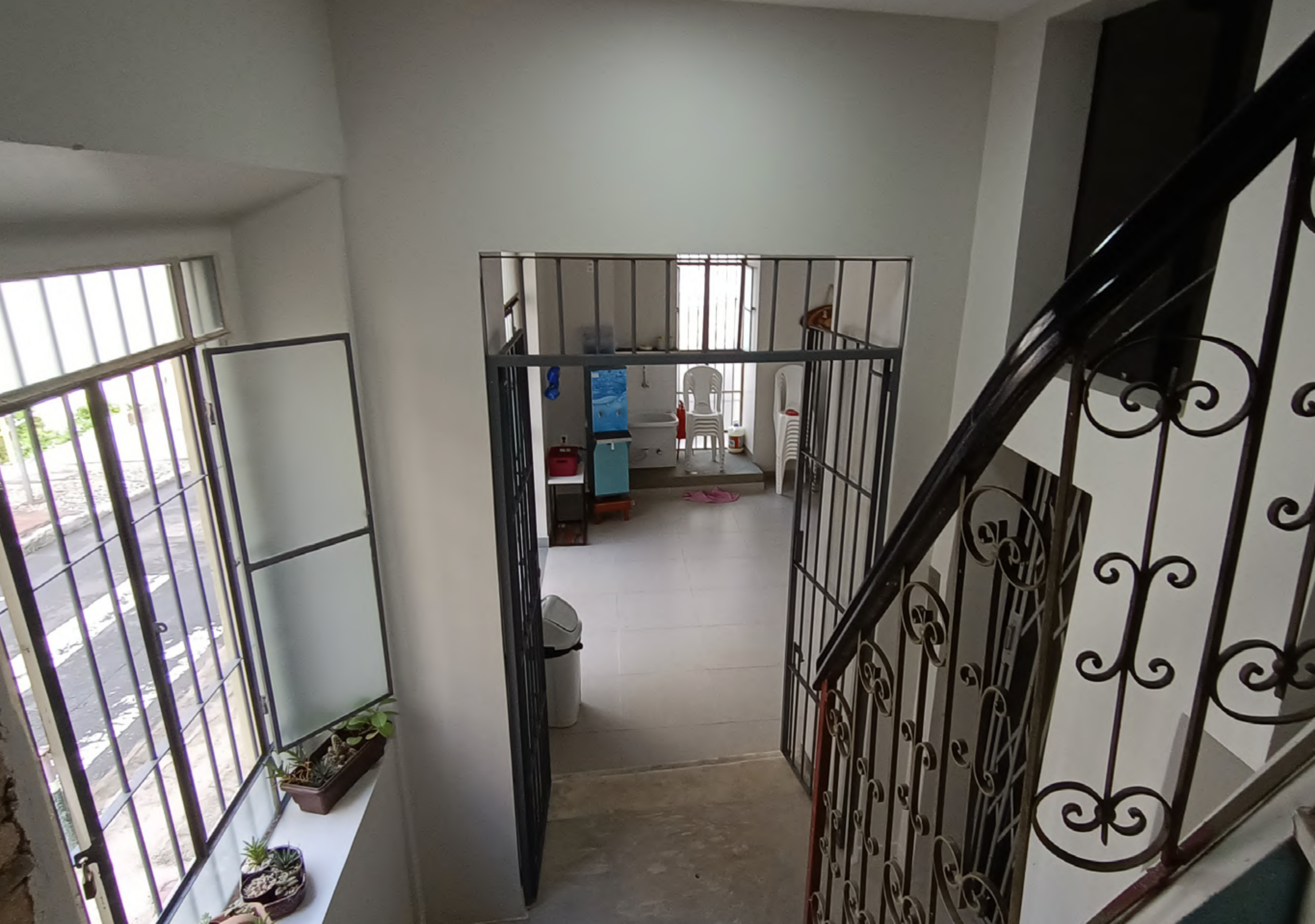
Escadaria para o 1º Pavimento
